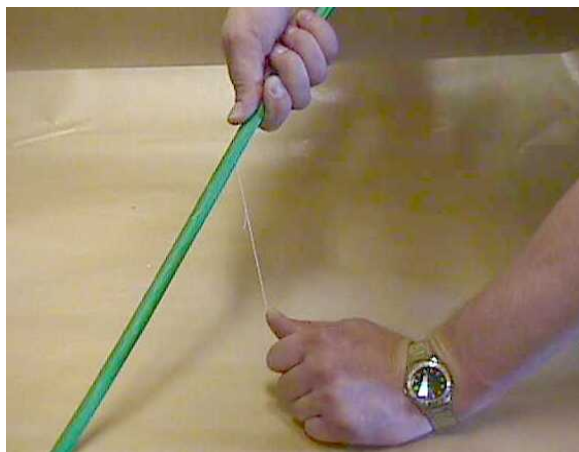
Skalning av kabel med hjälp av rivråd.
