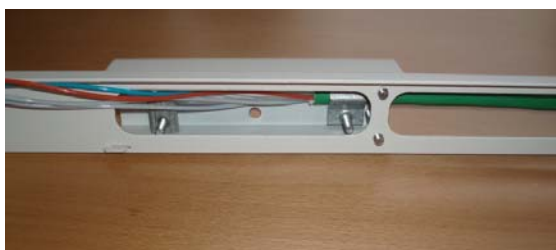
Kabel indragen och fäst i box.
