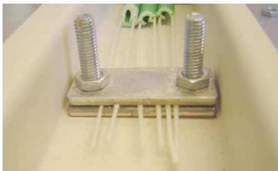
Första lagret dragavlastat.
