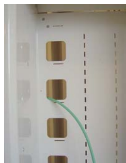
Hål i stativ för kabel
