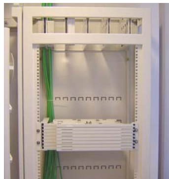
Placering av skarvmodul 1
