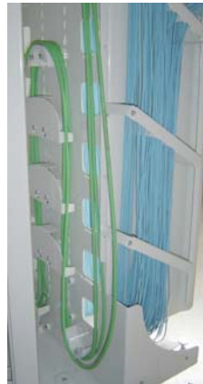
Friläggande av kabel
