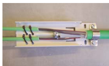
Monterade tuber och kabel
