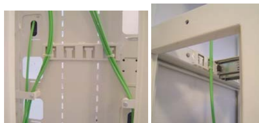
Fästpunkt innerstativ Fästpunkt ytterstativ
