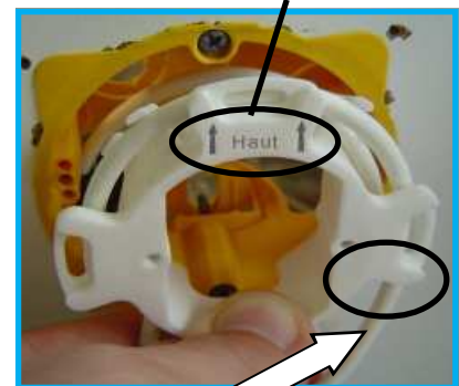
Sortie du câble abonné Exit of the subscriber's cable
