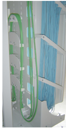
Friläggande av kabel
