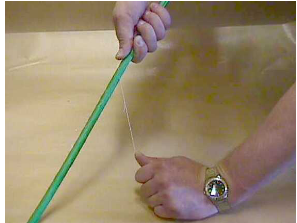
Skalning av kabel med hjälp av rivtråd
