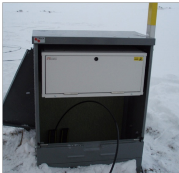
Överlämningsenhet monterad i ett markskåp.
