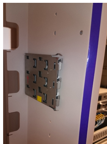
Sidoplåt monterad med pil uppåt
