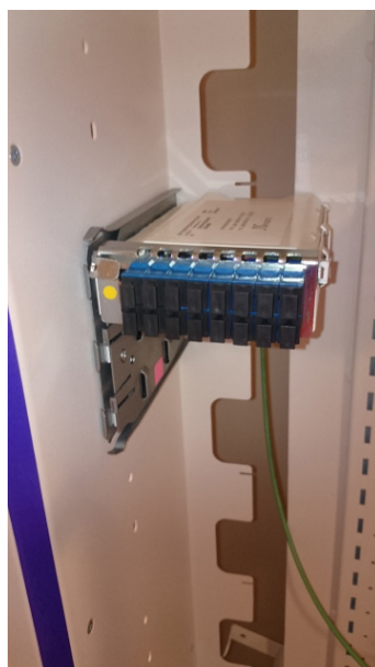
Modulen skjuts in och snäpper fast mot sidoplåten
