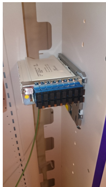
Modulen skjuts in och snäpper fast mot sidoplåten
