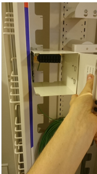
Beröringsskyddet träs på och snäpper fast
