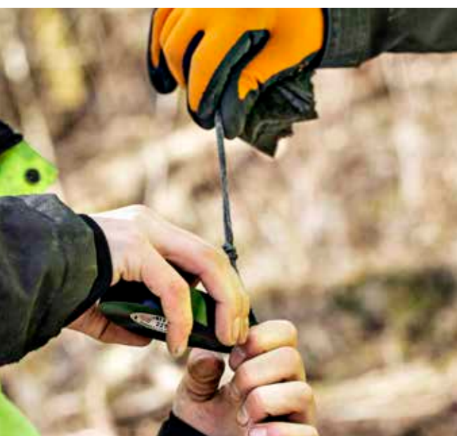
Med ny tunnare fiber blåser Blacklink huvudkabeln med 384 fiber hela 3 kilometer. När kabeln delats efter vägen slutar det med två fiber in i hemmen.
