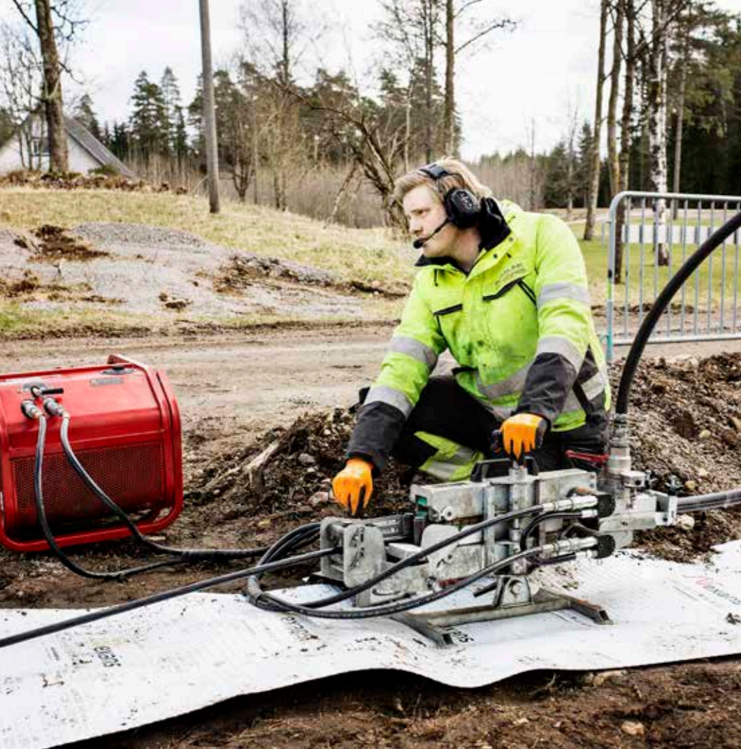
Markus Lerby håller koll på huvudkabeln när den blåses iväg i ett rör under marken.
